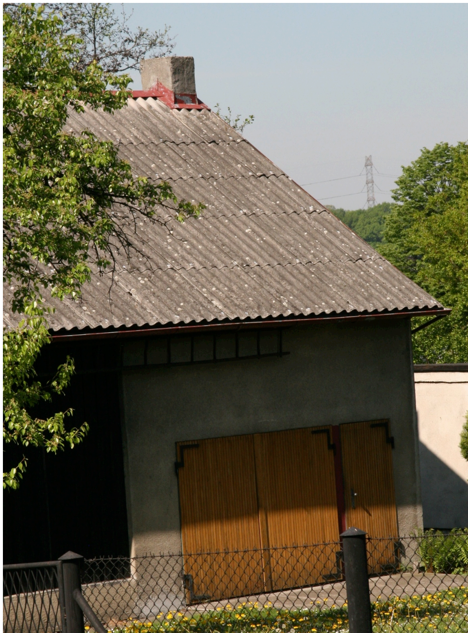
Rysunek 3 Dach pokryty płytami azbestowymi falistymi
